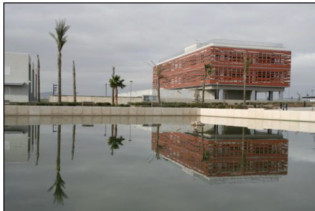
Edificio donde se ubicarán los Laboratorios del area Biomasa GEOLIT, Mengíbar, Jaén
